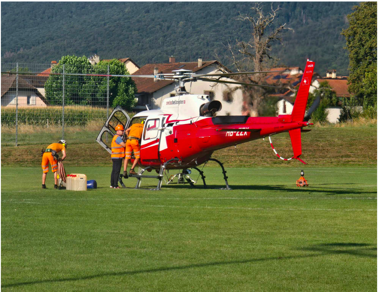
Préparation travaux hélicoptés mâts d'éclairage
